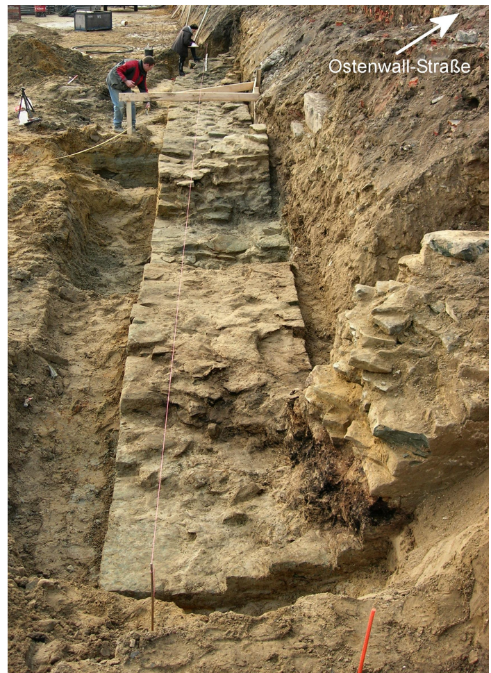
Abb. 7: Südliche Grundmauer des Wehrturms der Stadtburg am Nordenwall, Blick von Osten, 2006.
